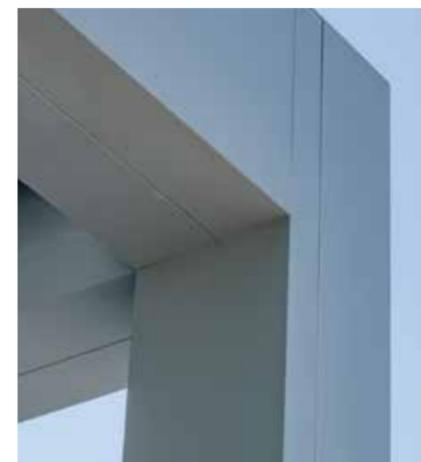
Besonders zuverlässig und unkompliziert lässt sich der clima Q.bus XL mithilfe seiner zweiteiligen Stützen montieren
